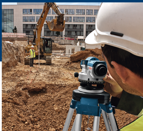
Excavación y cimentaciones
