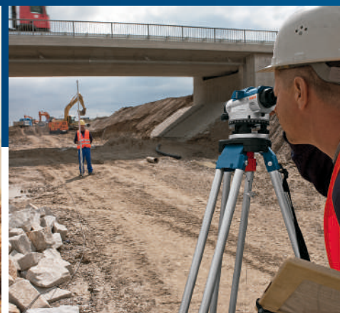
Nivelación de superficies
